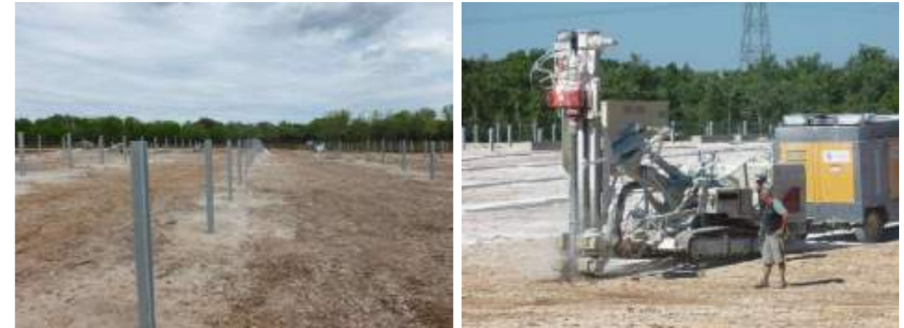
Figure 114 : Exemple de pieux battus et de leur mise en place
