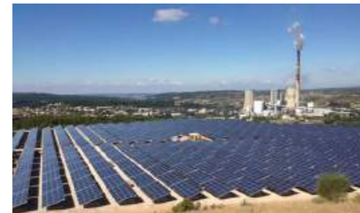
Figure 103 : Réalisation Urbasolar : aménagement d'un ancien terril à Gardanne (13)
