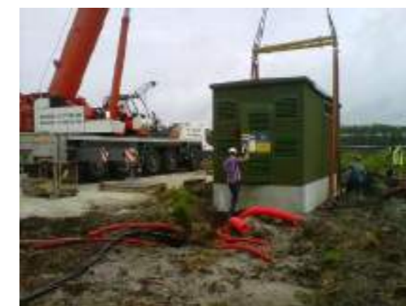
Figure 115 : Exemple de déchargement d'un poste de livraison
